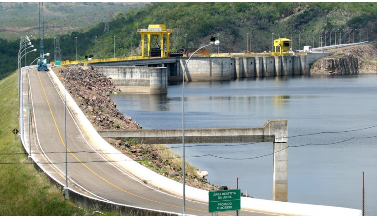
Proágua - Canal Sistema Barragem - Pedra do Cavalo Foto: Eraldo Peres / Banco de Imagens da ANA
