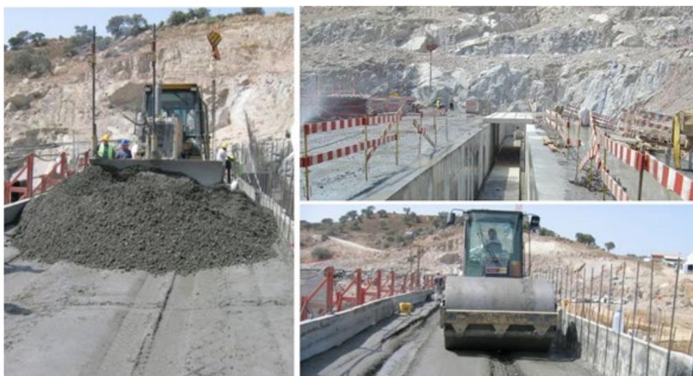
**Figura 30.** Aspectos da construção de blocos em CCR.
