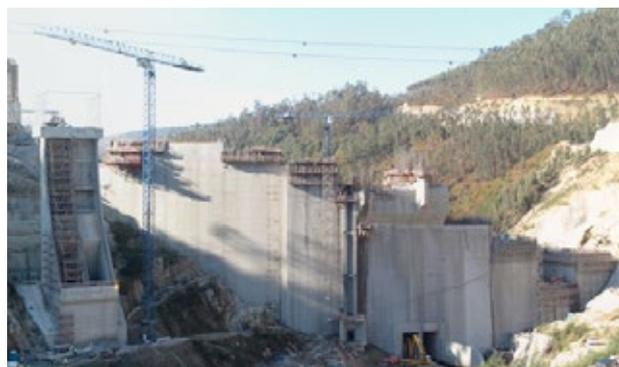
**Figura 25.** Barragem de concreto convencional (Barragem de Ribeiradio, Portugal).
