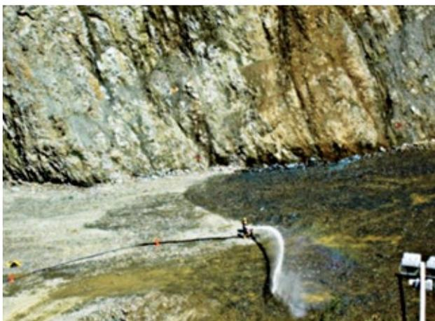
**Figura 20.** Irrigação do aterro de enrocamento.
