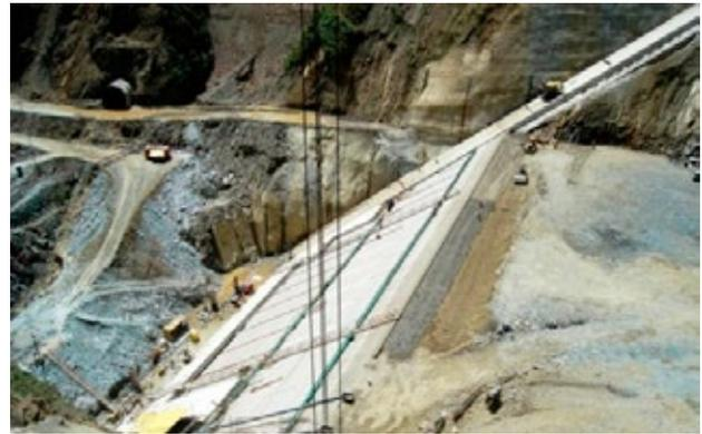
**Figura 17.** Construção de uma barragem de enrocamento com face em concreto e plinto de fundação.
