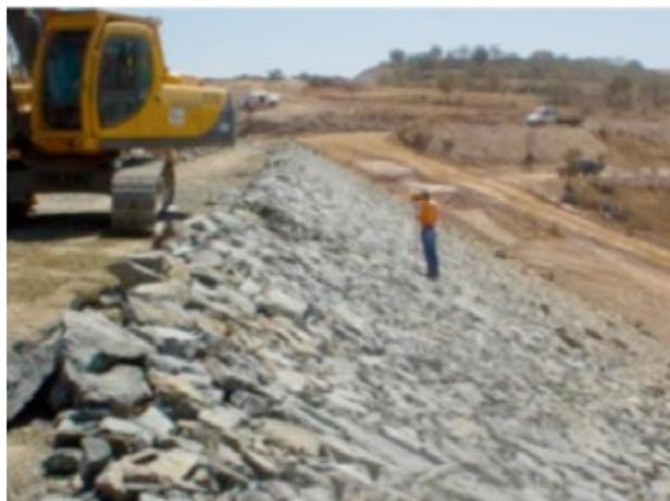
**Figura 13.** Proteção do talude de montante em enrocamento.
