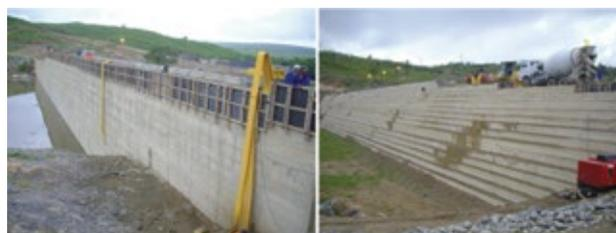
**Figura 27.** Barragem de concreto compactado a rolo (CCR). Barragem do Mamoeiro, CE.
