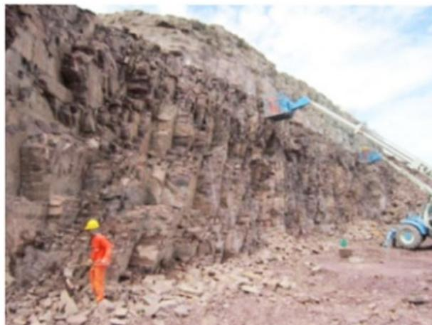
**Figura 6.** Remoção de blocos soltos.
