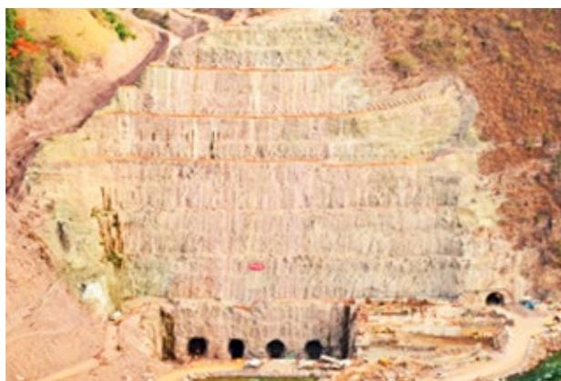
**Figura 4.** Escavação a céu aberto da saída do segundo circuito hidráulico de Cambambe, Angola.
