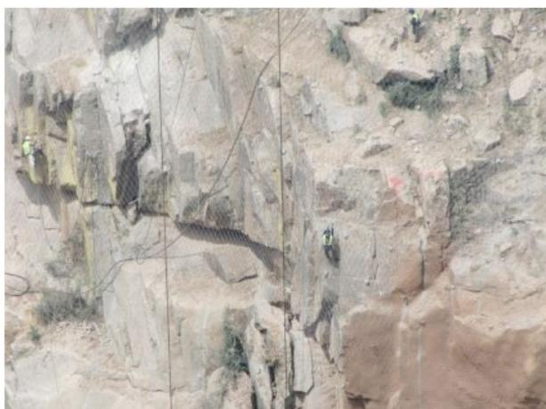
**Figura 5.** Escavação com proteção em rede metálica.
