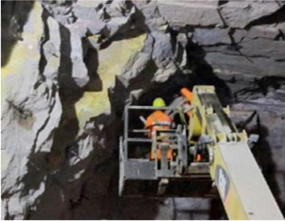
**Figura 12.** Escavações subterrâneas. Remoção de blocos soltos.
