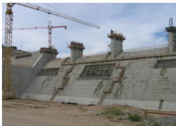
**Figura 28.** Barragem de concreto compactado a rolo (CCR) (Barragem de Pedrógão, Portugal).
