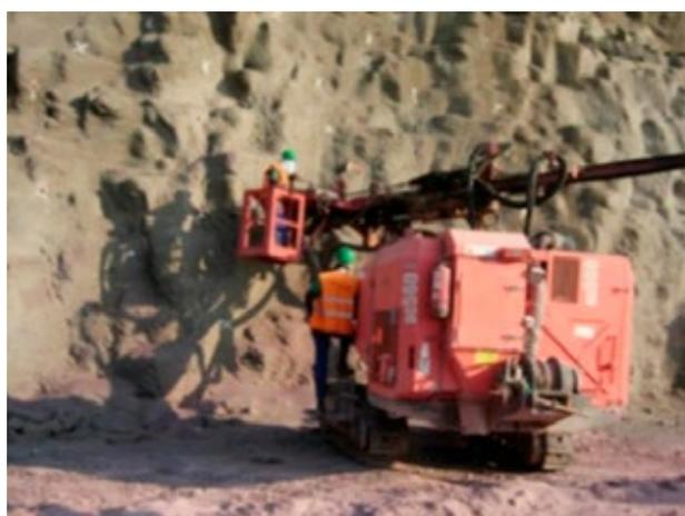
**Figura 8.** Aplicação de chumbadores após concretagem.
