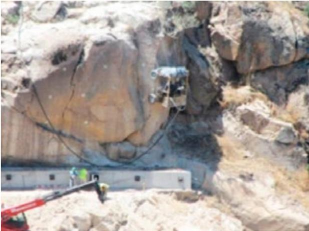
**Figura 9.** Viga de ancoragem ativa.
