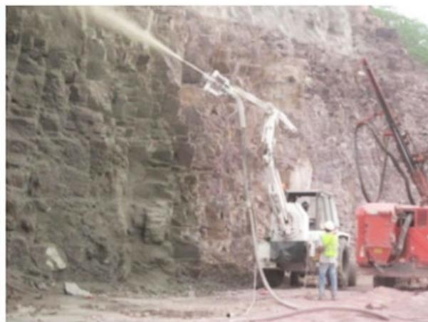
**Figura 7.** Projeção de concreto.
