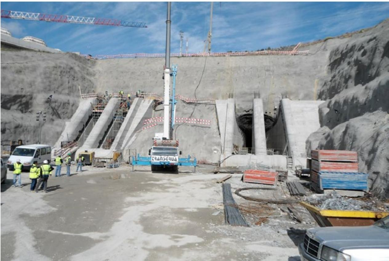
**Figura 36.** Tomadas de água numa das vertentes seguida de túnel. Barragem do Baixo Sabor, Portugal.
