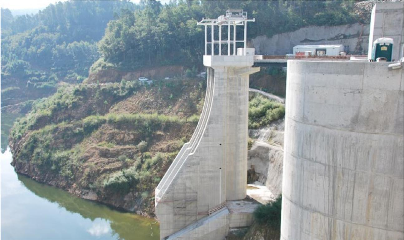
**Figura 35.** Tomada de água em torre, adjacente à barragem de concreto. Barragem de Ribeiradio, Portugal.
