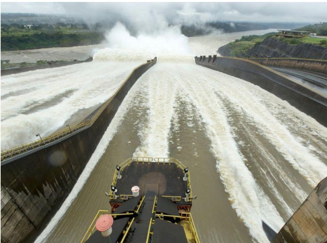
**Figura 37.** Formação de ondas estacionárias de frente abrupta na barragem de Itaipu. Vista lateral e vista de montante.
