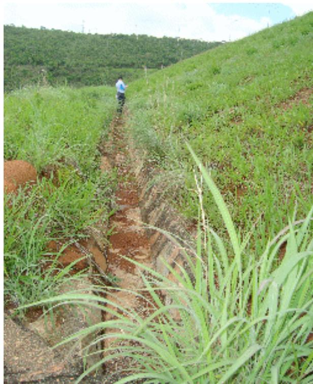
**Figura 1.5.** Canaletas de drenagem necessitando de limpeza de solo no fundo.
