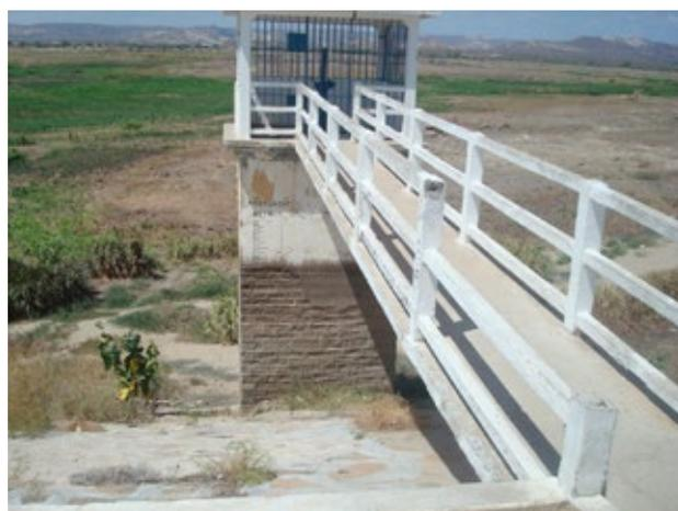
**Figura 1.13.** Barragem de Santa Luzia (Paraíba) – passadiço e tomada de água.
