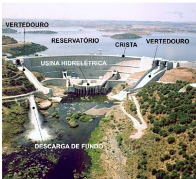
**Figura 1.26.** Vista geral da barragem de Alqueva (Portugal) – região a jusante.
