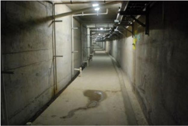
**Figura 1.14.** Galeria de drenagem da barragem em CCR da UHE 14 de Julho (Rio Grande do Sul).
