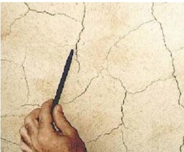
**Figura 19.** Aparecimento de fissuras.
