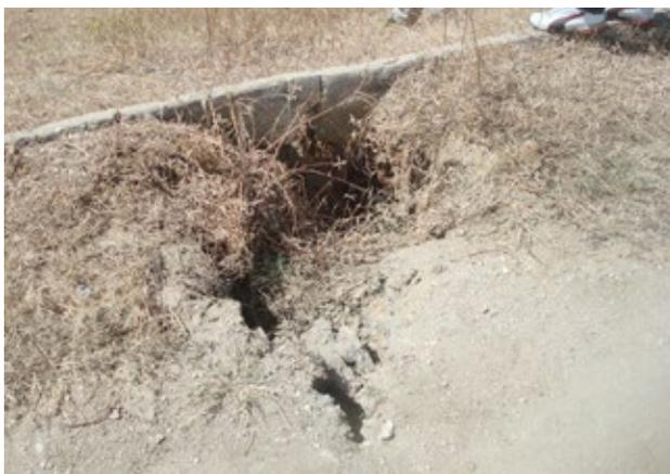
**Figura 1.3.** Barragem de Baião (Paraíba) – Erosão do talude de jusante.
