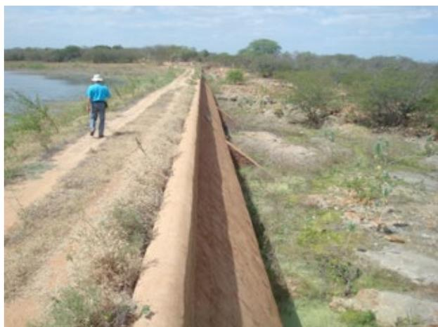
**Figura 1.10.** Barragem de Direito (Paraíba) – soleira descarregadora da barragem.
