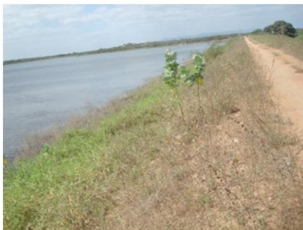
**Figura 1.1** – Barragem de Direito (Paraíba) – talude de montante com vegetação.
