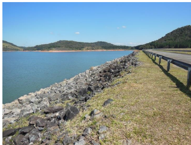
Figura 8– Vista de montante da barragem Jaguari
