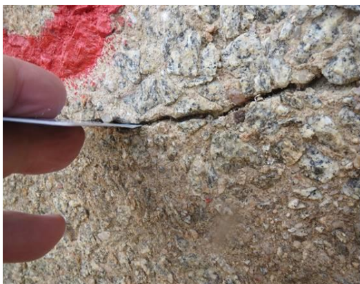
Figura 10 – Manchas na ombreira
