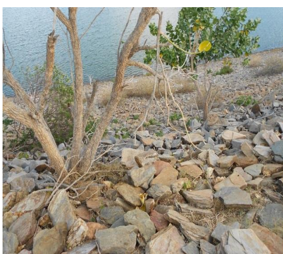
Figura 6 – Vegetação no talude de montante
