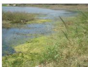
Figura 1.13. Barragem XXXXXXX - Reservatório com vegetação abundante.
