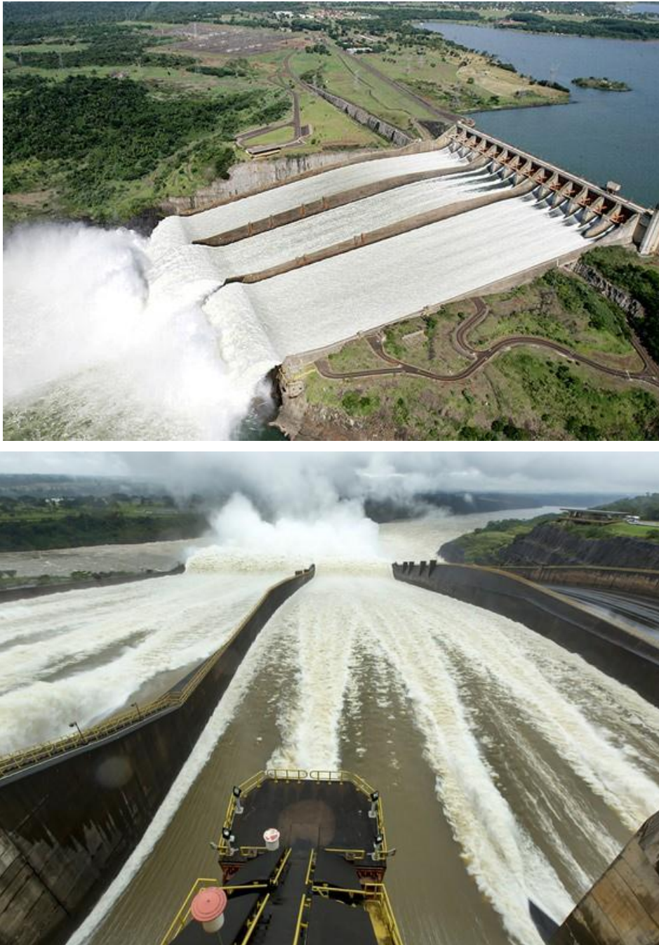
Figura 37. Formação de ondas estacionárias de frente abrupta na barragem de Itaipu. Vista lateral e vista de montante. (Fonte: SBB, Engenharia)
