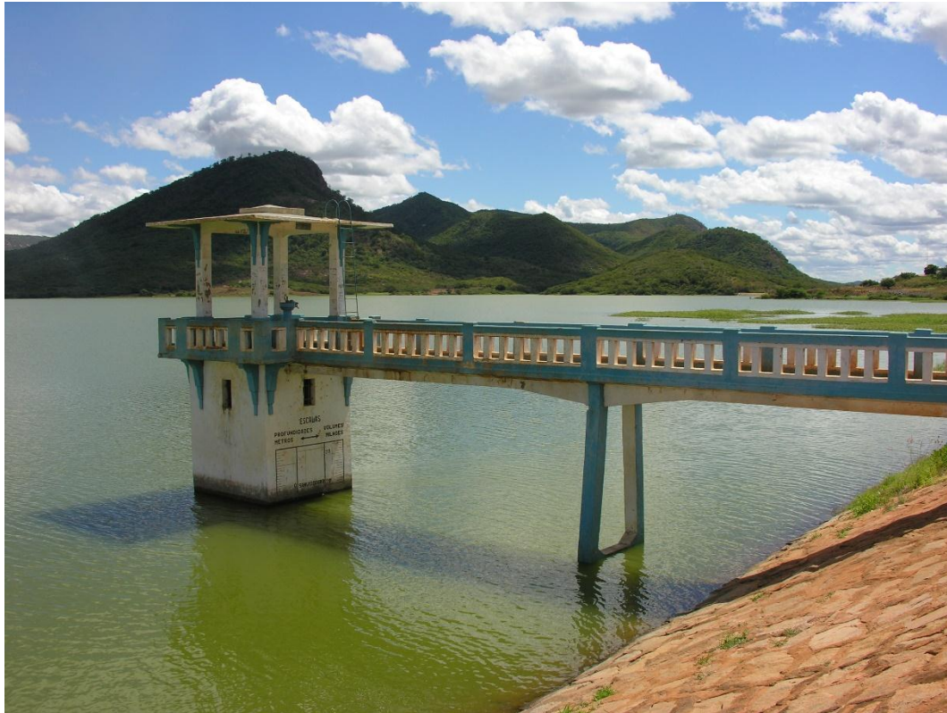
Figura 34. Tomada de água em torre com acesso, por passadiço, à barragem de aterro. Barragem de Lucrécia, RN. (Fonte: Secretaria de Recursos Hídricos do Rio Grande do Norte, SEMARH-RN)
