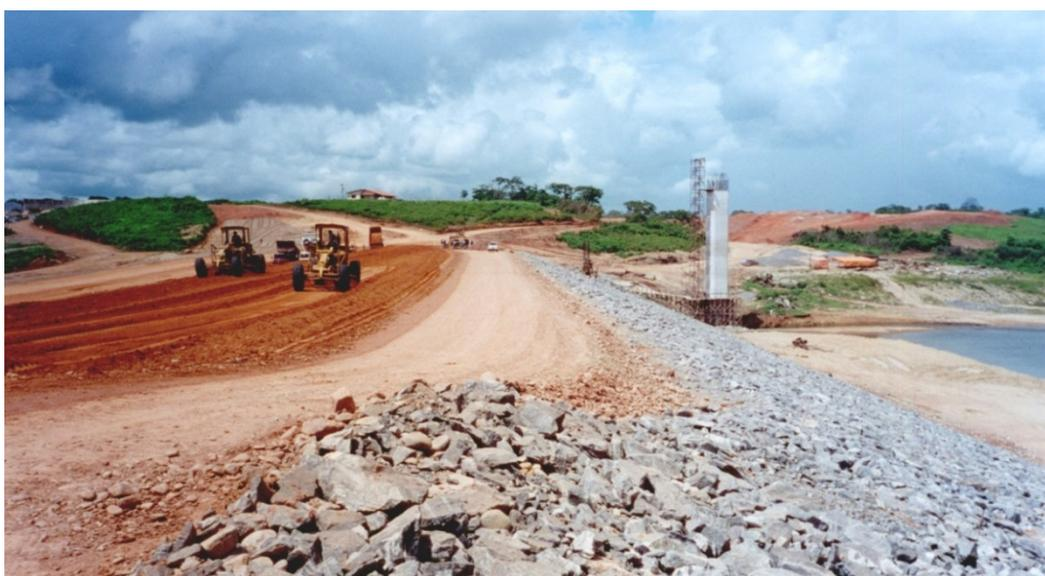
**Figura 14. Barragem de Aracoiaba, CE – construção H=35m, V=170 hm<sup>3</sup>, L=2000 m.**
