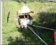
Foto 1.5 - Poço do de água junto ao pé da barragem, nas proximidades do O.D.
