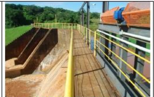
Foto 7.2 – Boas condições e bom alinhamento da crista do Vertedouro.
