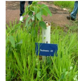
Foto 11.1 - Piezômetro com vegetação excessiva no entorno.
