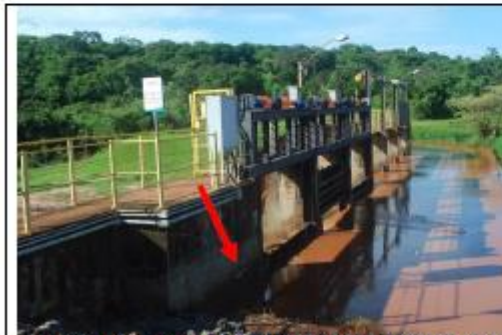
Foto 7.1 – Vista geral a partir de montante e exposição de agregado na esquerda hidráulica (seta).
