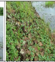
Foto 1.2 - Detalhe ilustrando o bom estado dos blocos de rocha.
