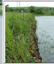
Foto 1.1 - Vista geral do rip-rap a montante.
