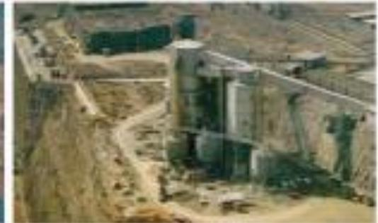
Três instalações verticais de produção de concreto (cada uma produzindo 200m<sup>3</sup>/hora) com uma betoneira central basculante que foram usadas por mais de 40.000 horas para produzir mais de 8.000.000 m<sup>3</sup> de concreto massa em Itaipu (margem esquerda) - Brasil - 1977 até 1983 (Barragem Itaipu - foto por Andriolo)
