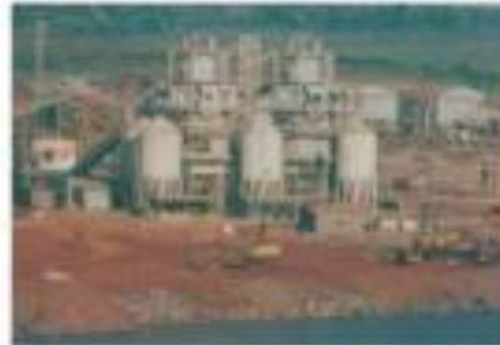
Duas instalações verticais de produção de concreto (cada uma produzindo 200m<sup>3</sup>/hora) com uma betoneira central basculante que foram usadas por mais de 40.000 horas para produzir mais de 8.000.000 m<sup>3</sup> de concreto massa em 4 grandes barragens no Brasil - 1966 até 1960 (Barragem de Ihu Solteira - foto por Andriolo)
